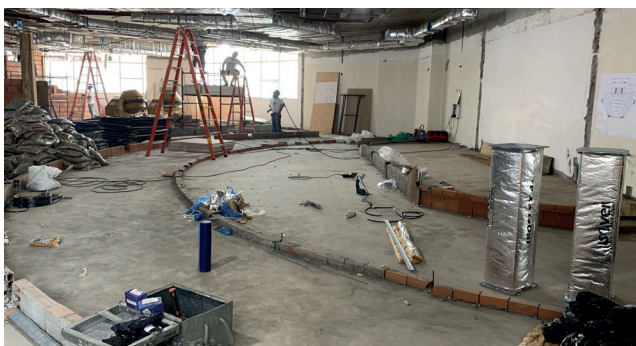
INÍCIO DA REFORMA DO AUDITÓRIO ANTES - NOVEMBRO DE 2020
