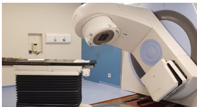
INSTALAÇÃO DO NOVO ACELERADOR DEPOIS - DEZEMBRO DE 2020
